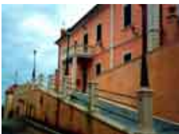
Castellina Marittima, ex-Palazzo Opera "Massimino Carrai", attuale sede del Punto Museale Centrale dell'Escavazione, prima e dopo il restauro.
