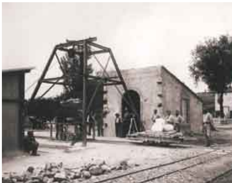
L'ingresso di una cava di alabastro a Castellina M.ma
